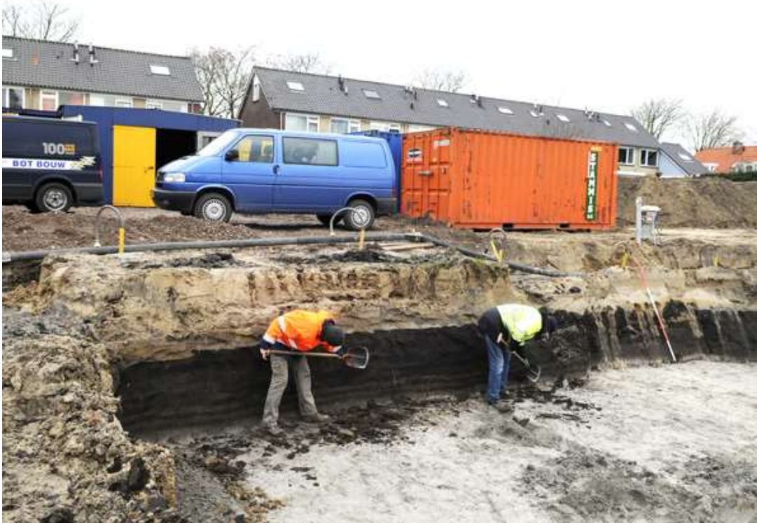
Het profiel wordt afgestoken.
