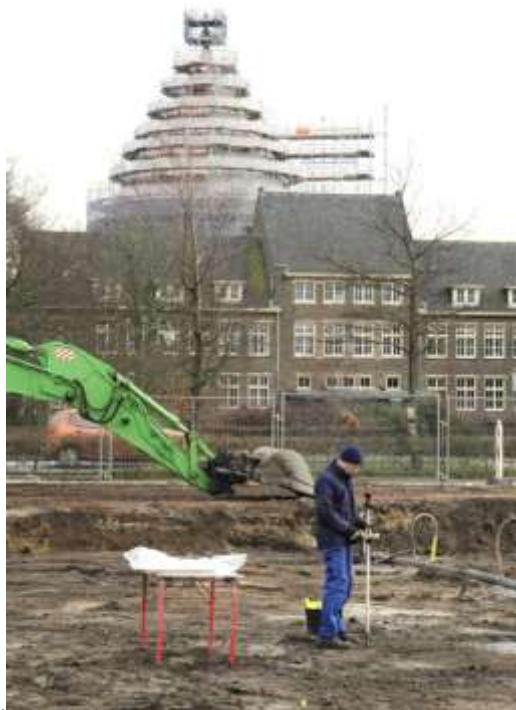
*Maatvoerder Bot Bouw, het uitzetten van piketten voor heipalen.
