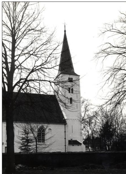
De Witte Kerk in 1967 na de restauratie (foto: ROB Amersfoort).
